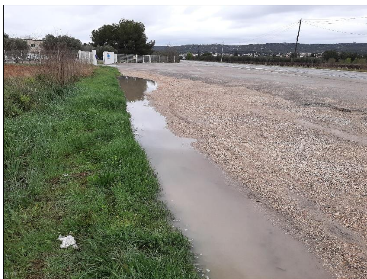
Figure 20 : Photographie d'ornières en eau en bordure est de la zone d'étude
