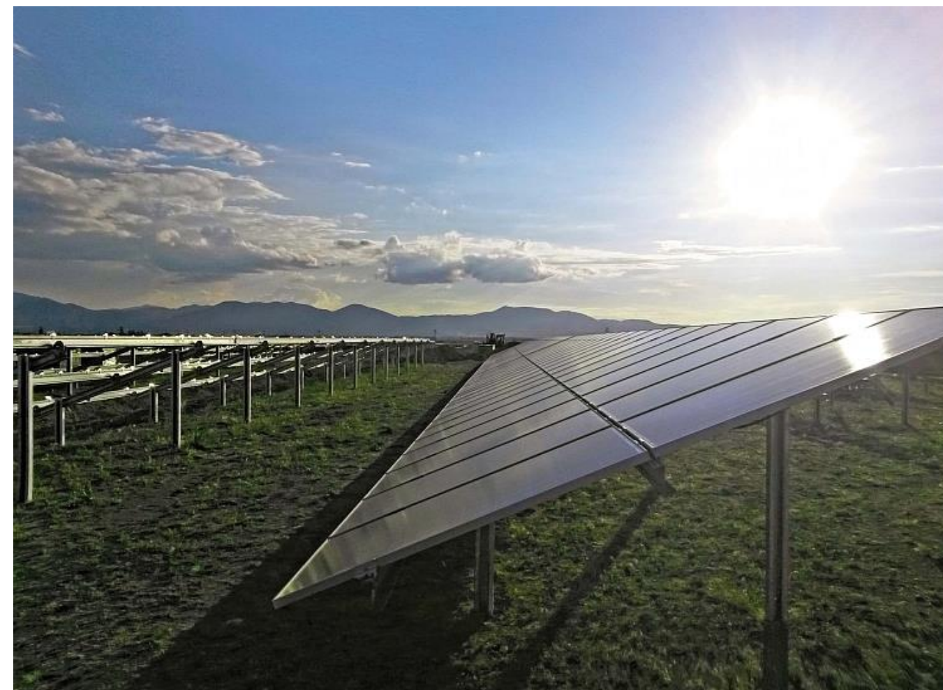
Figure 6 : Type de structure sur pieux battus (source : Schletter)
