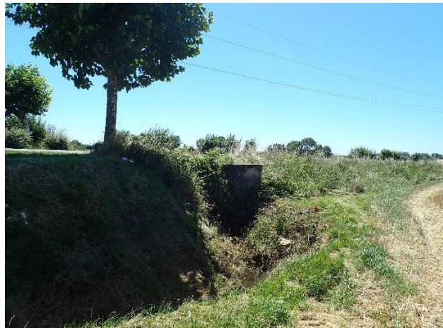
Photo 5 : Busage pour passage sous voirie
