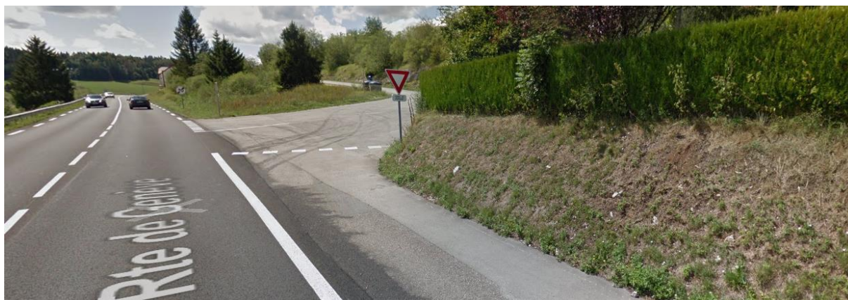
Photo ci-dessus : contre-allée réalisée le long de la RN5 et carrefour élargi côté Sud
