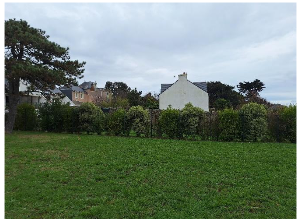
Pas d'ouverture côté Ouest.
