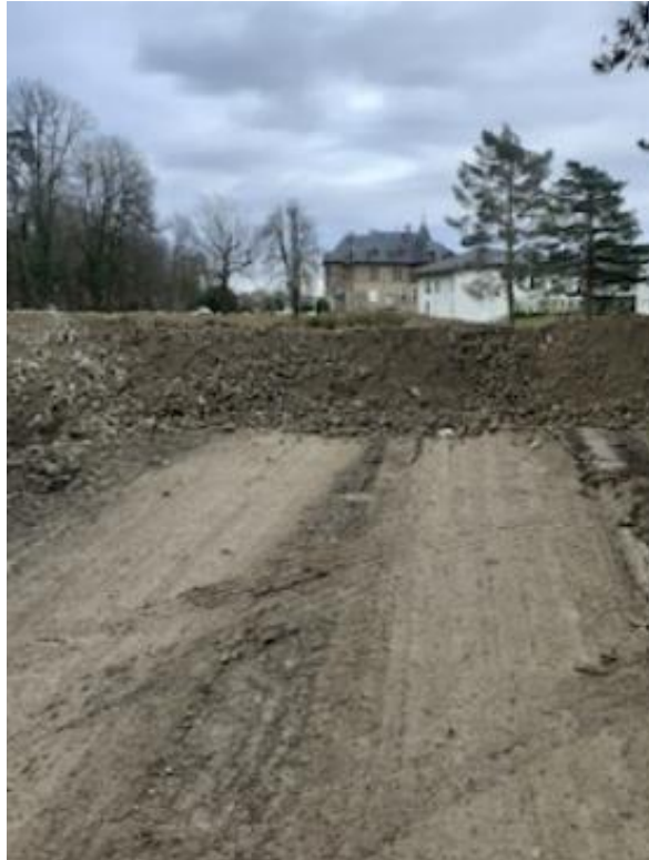
Figure 19 : Planche photographique de la réalisation des travaux de déconstruction de l'existant en partie nord de l'AEI (de haut en bas : situation au 22 mai 2023, situation au 11 octobre 2023, situation au 27 octobre, situation au 8 novembre 2023, fin des travaux au 29 février 2024)
