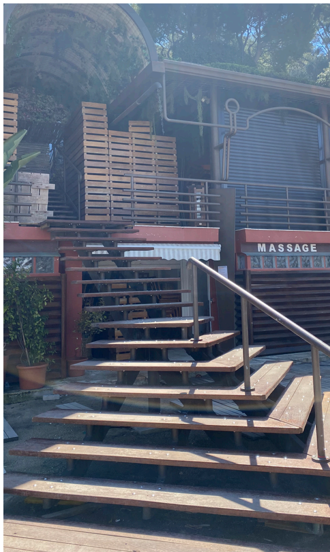
Installation Escalier central - Photos prises le 27 et 28/03/23
