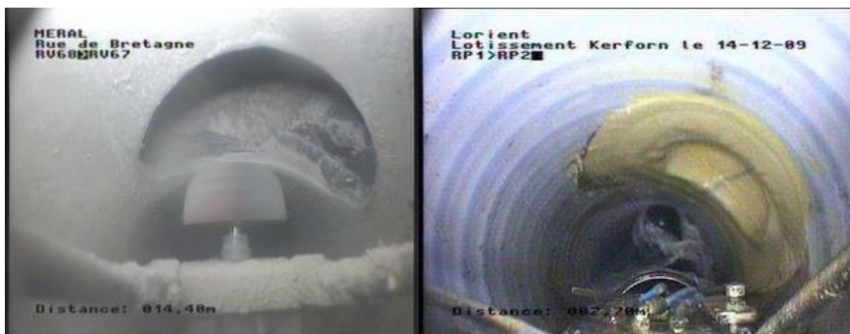
Photo 4 : Réouverture des branchements par l'intérieur après chemisage et pose d'un Top-Hat
