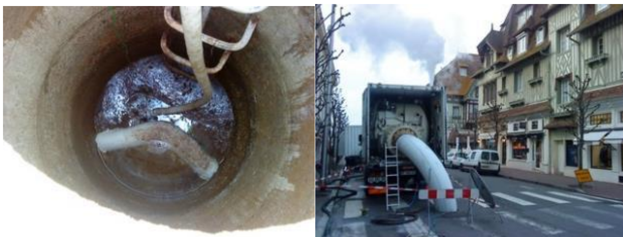
Photo 4 : Réouverture des branchements par l'intérieur après chemisage et pose d'un Top-Hat
