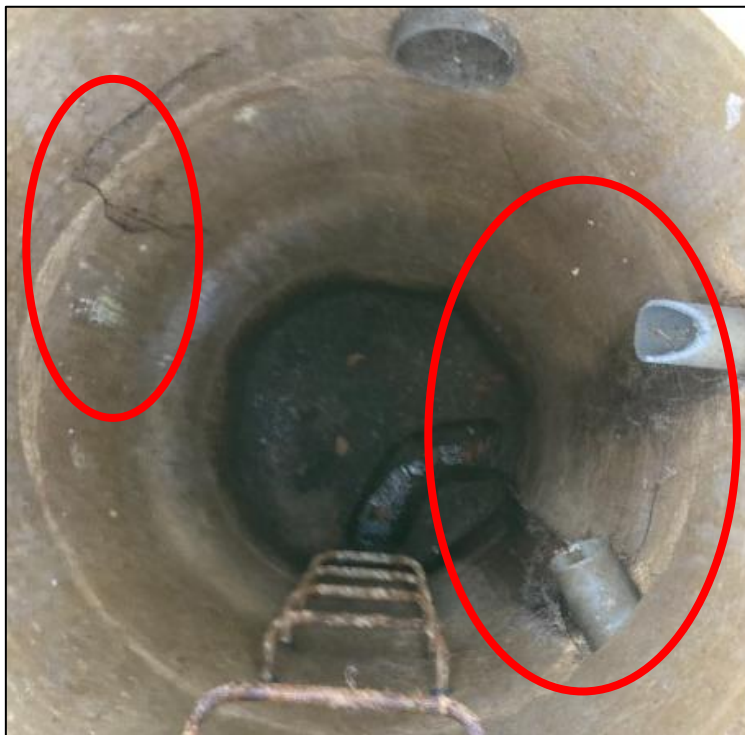
Figure 6 : Regard EU avec intrusion racinaire
