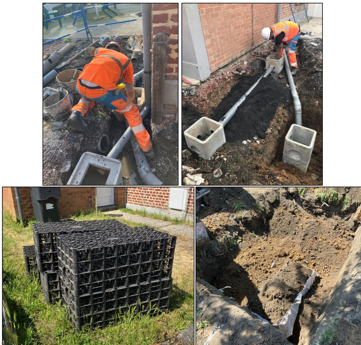
Figure 9 : Illustration de travaux de déconnexion des EP en domaine privé
