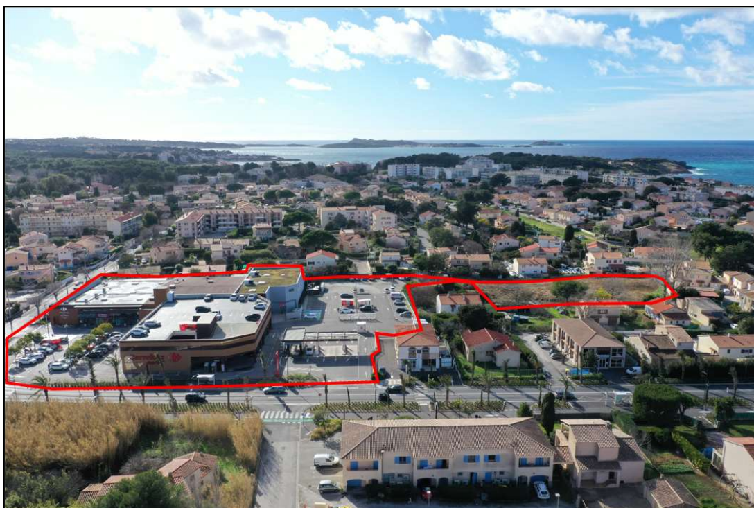
Figure 7 . Vue aérienne du site actuel (janvier 2025), prise de vue du nord.
