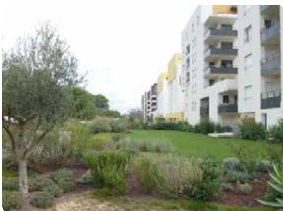
Abords d'immeubles (quartier Grisettes à Montpellier)
