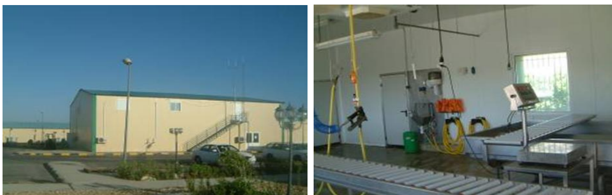
Figure 42 : Unité de conditionnement et de stockage et Salle de conditionnement.
