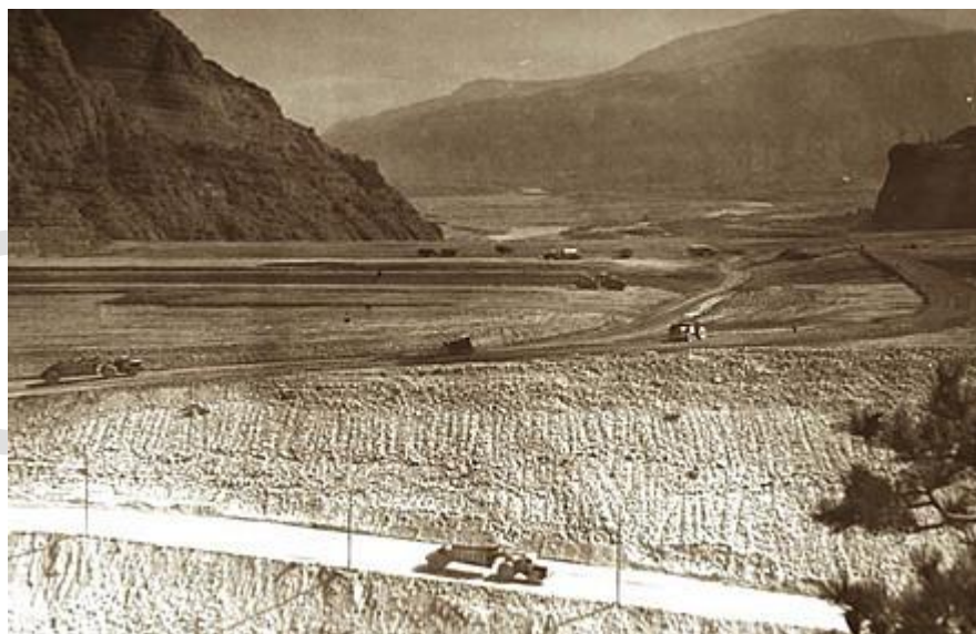
Figure 1 : Début des travaux du barrage en 1955
