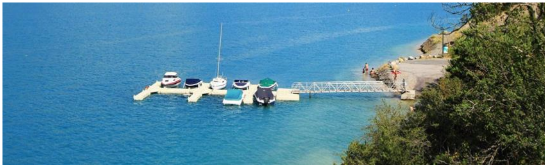
Figure 25 : Ponton de la Bréole.
