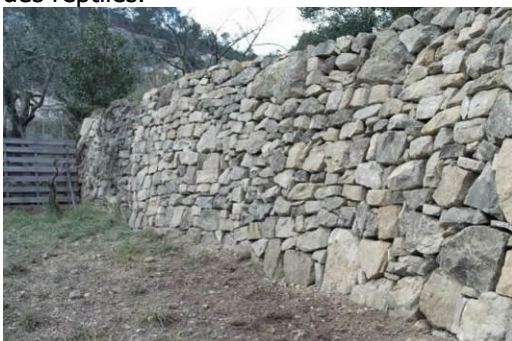
- Murs de pierre sèche
