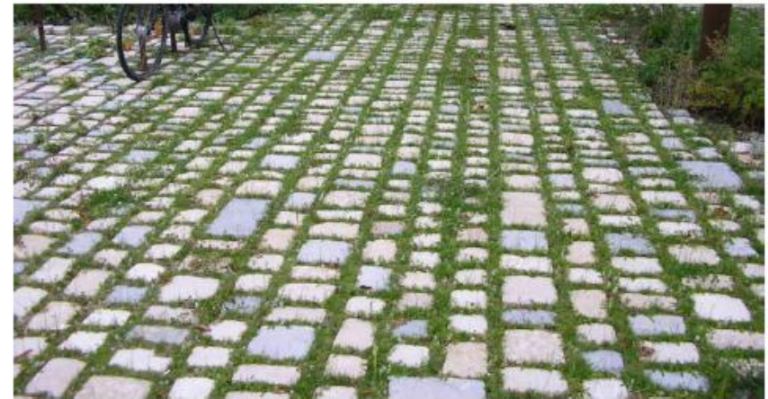
Parking en pavés pierre naturelle et joints engazonnés
