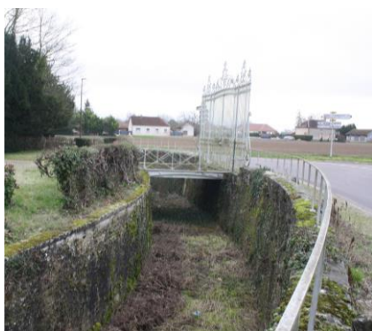
Fossé du jardin du « château »
