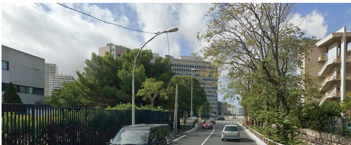
Photo 4. Vue Sud-Ouest depuis le boulevard de la Gaye (octobre 2024, Google Streetview)
