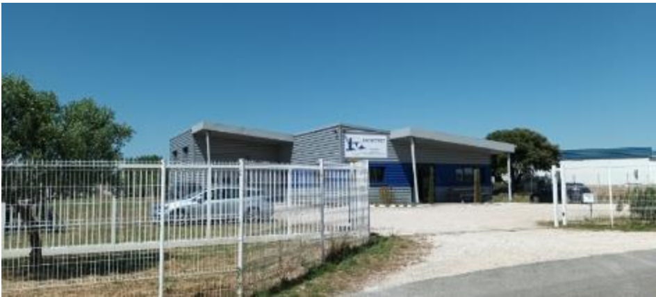
Figure 5 : Local industriel (imprimerie)
