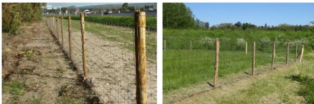
Exemple d'une clôture de parc solaire – Source Melvan
