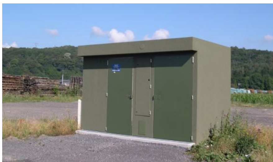
Exemple de poste de livraison/transformation
