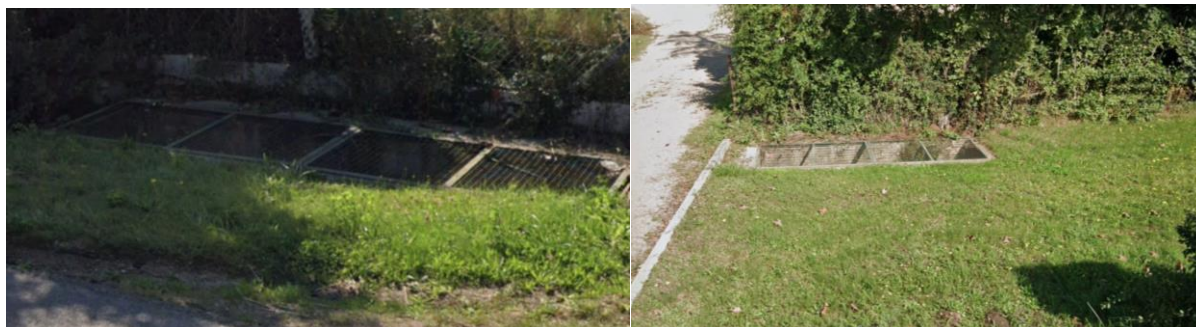
Figure 13 : Vues des dégrilleurs/dessableurs de la Rue d'Avallon (D606)
