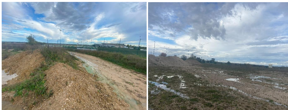
Figure 11 : photographies du site
