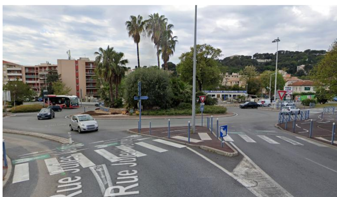
Giratoire M336 / Rue Jules Vernes – depuis centre-ville (2023)
