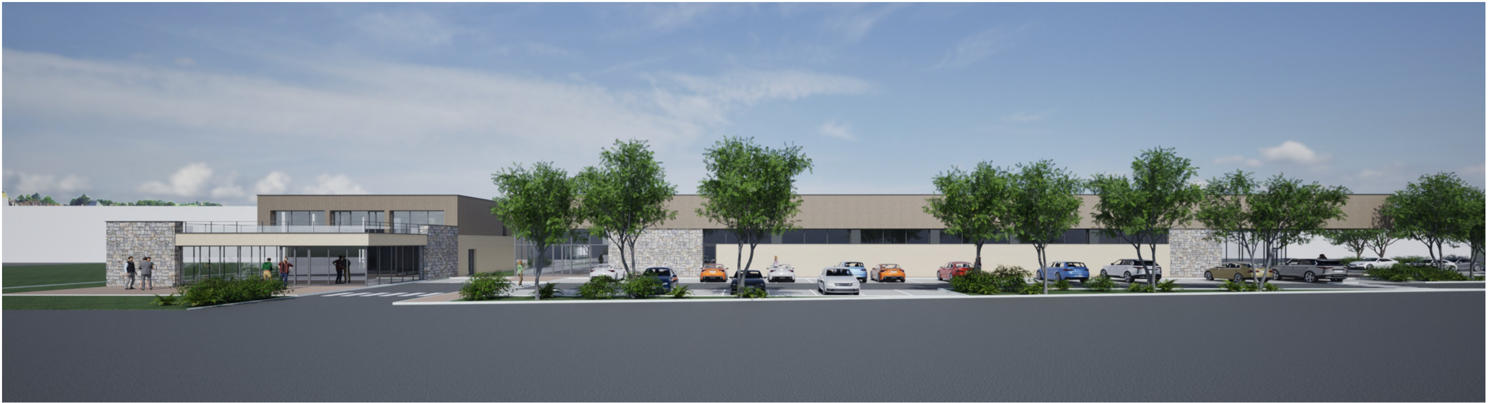
Vue principale depuis le Boulevard
