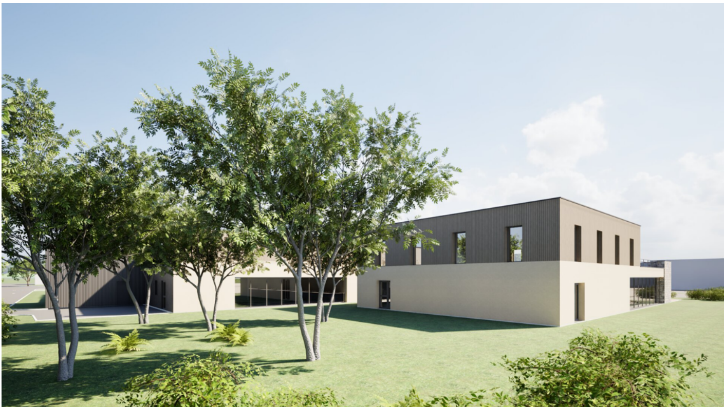
Vue de derrière
