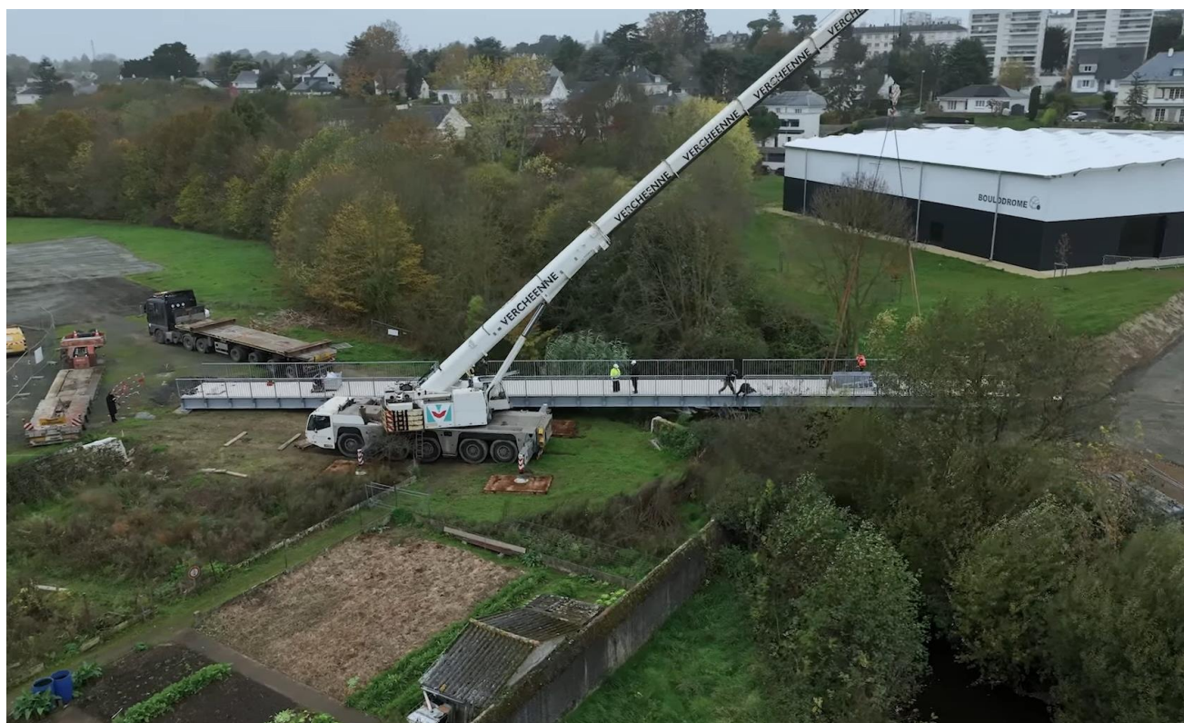
Vue aérienne de la passerelle (à l'est du projet) lorsqu'elle était en construction (2024)
