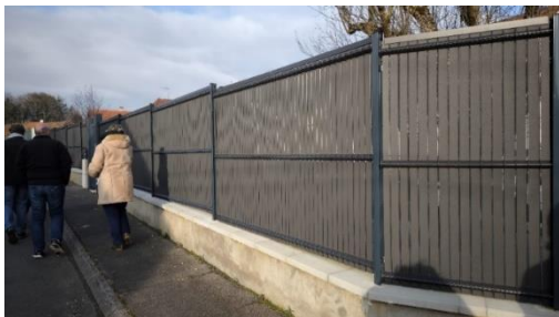
Exemple de clôture haute à faible clairevoie en lames PVC à Nommay
