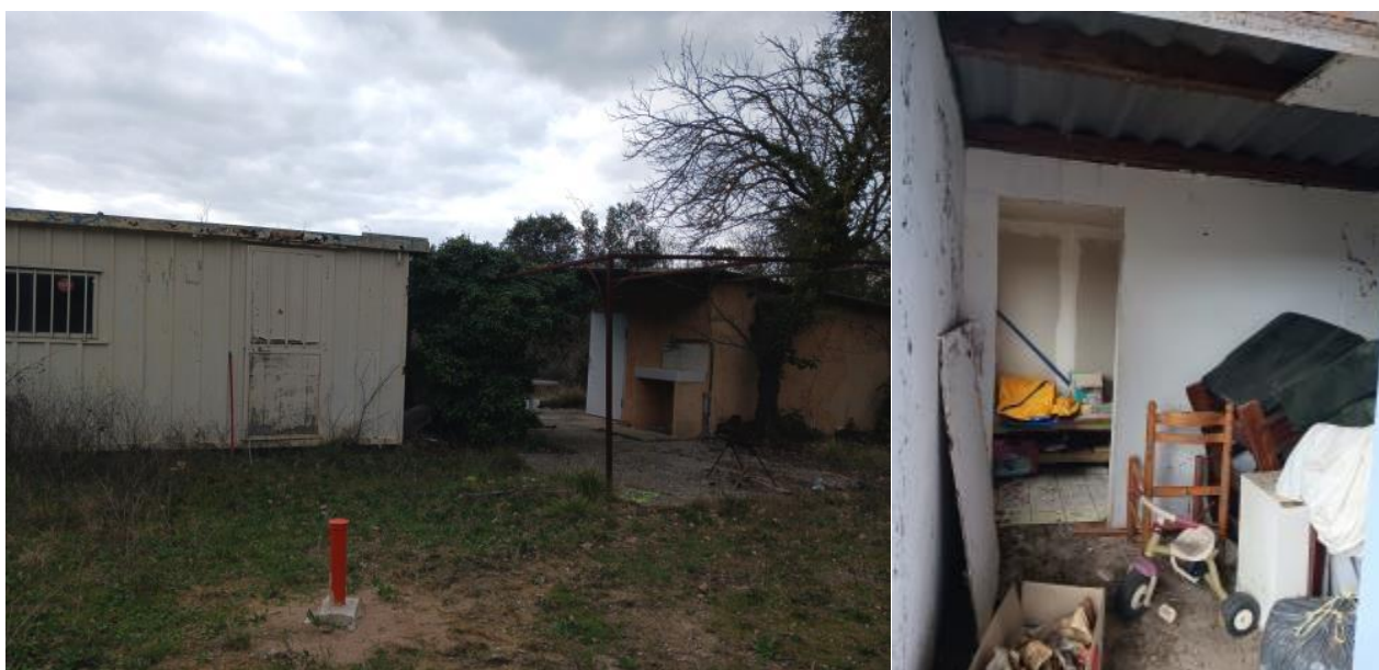
Figure 5 Cabanon de faible densité
