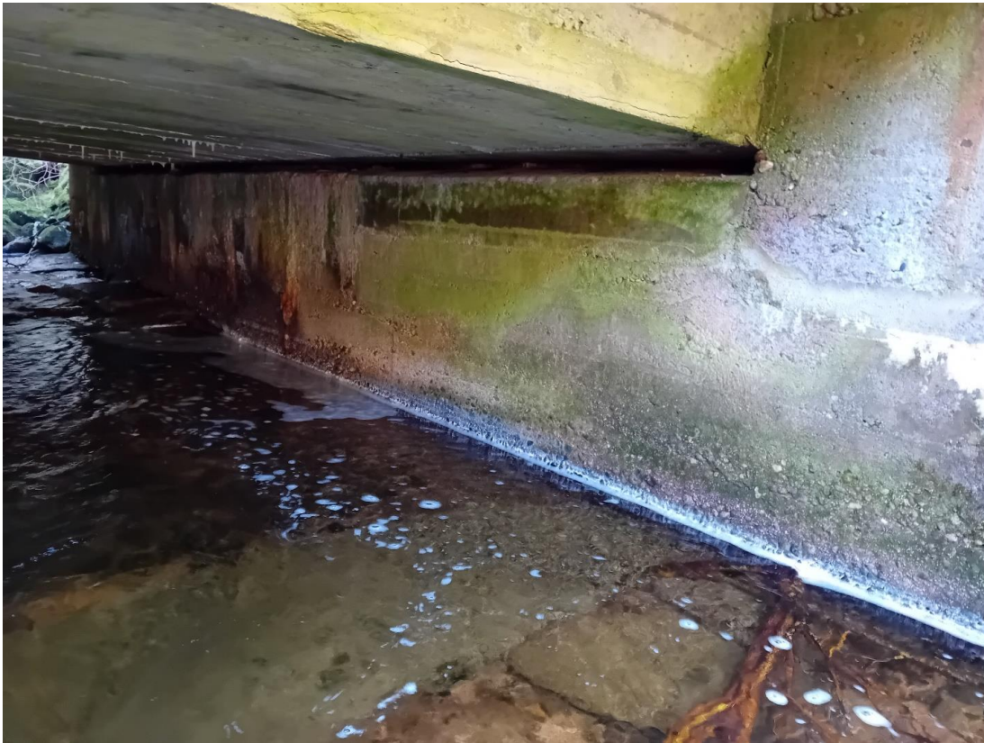
Piédroit Rive gauche aval :
