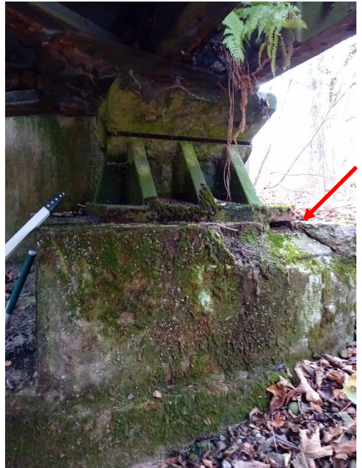
Appui rive droite amont : éclat de béton
