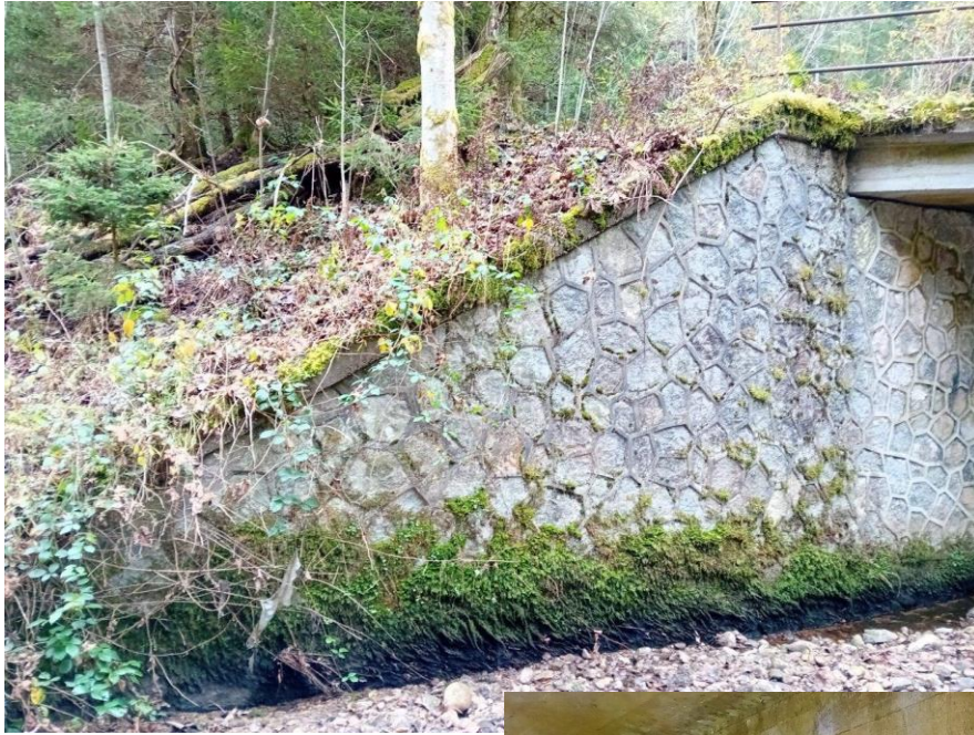
Mur en aile amont
