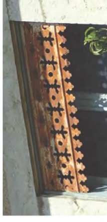
9. Masquer le caisson des volets-roulants
