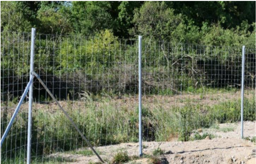
Figure 12 – clôture à mailles progressives à Argent-sur-Sauldre (18)
