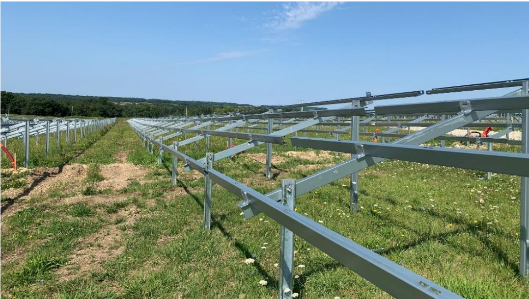
Figure 7 : Photographie des structures
