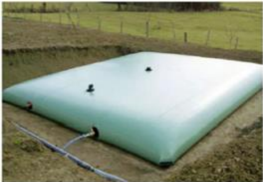
Figure 4 : Exemple de réserves d'eau artificielles métalliques (à gauche) et souple (à droite)
