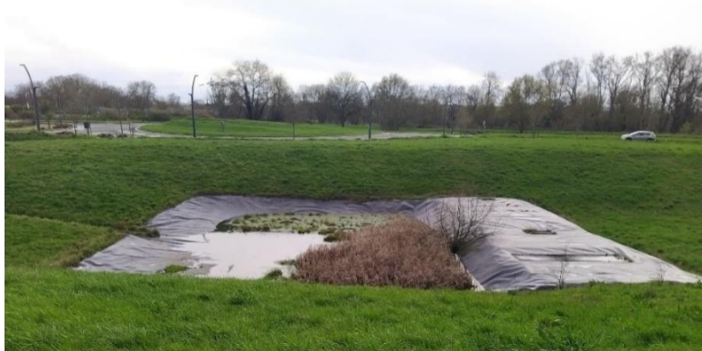
Illustration 1 : Bassin de rétention sud du périmètre (23 février 2023)
