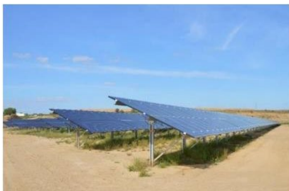
Figure 6 : Exemples de structures fixes et fondations par la méthode des pieux battus
