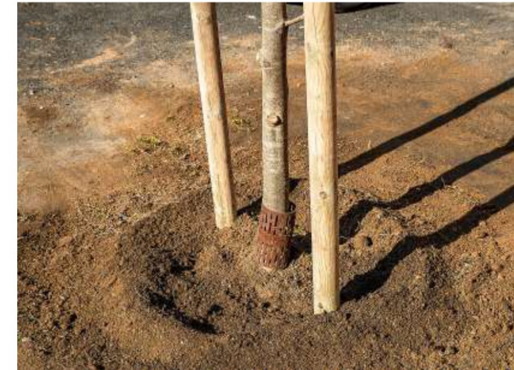
Plantation avec cuvette d'arrosage
