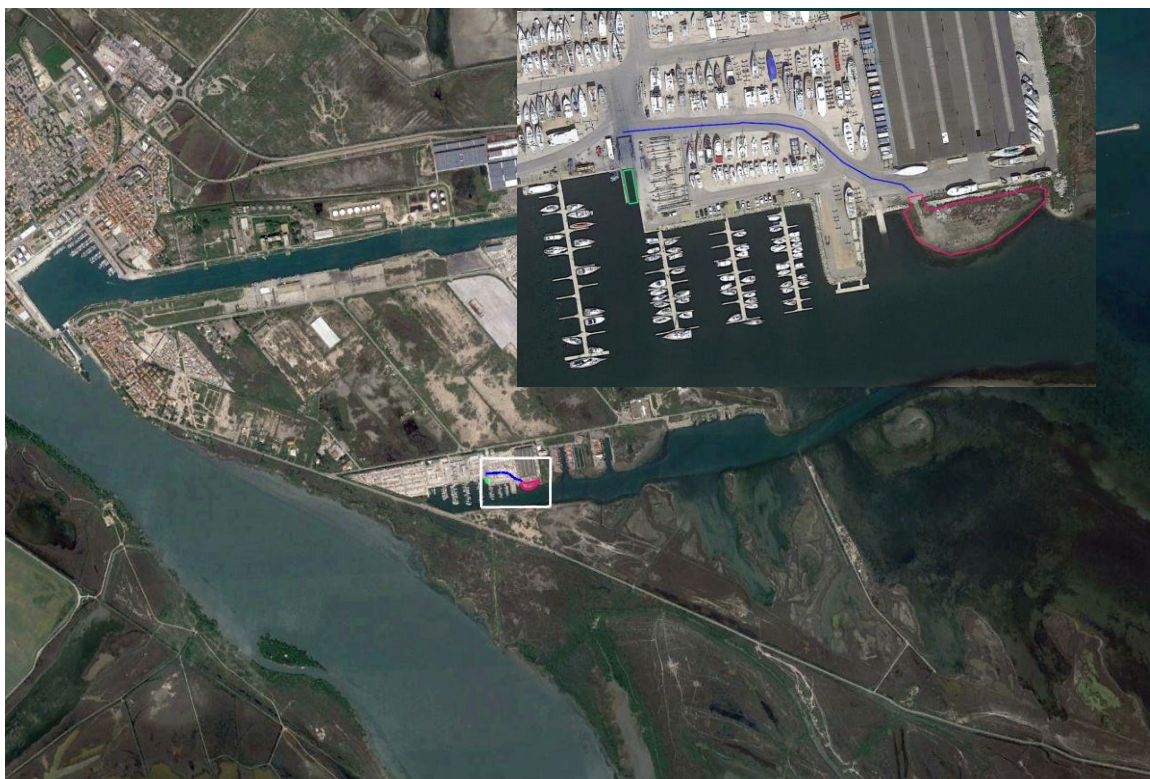
FIGURE 45 : LOGISTIQUE DE STOCKAGE DES RECIFS AU PORT DE NAPOLEON (ZONE ROUGE : LIEU DE STOCKAGE DES RECIFS, TRAIT BLEU : TRANSPORT DES RECIFS JUSQU'À LA ZONE DE GRUTAGE, ZONE VERTE : MISE A L'EAU DES RECIFS PAR LA GRUE 4 M DE TIRANT D'EAU DISPONIBLE)
