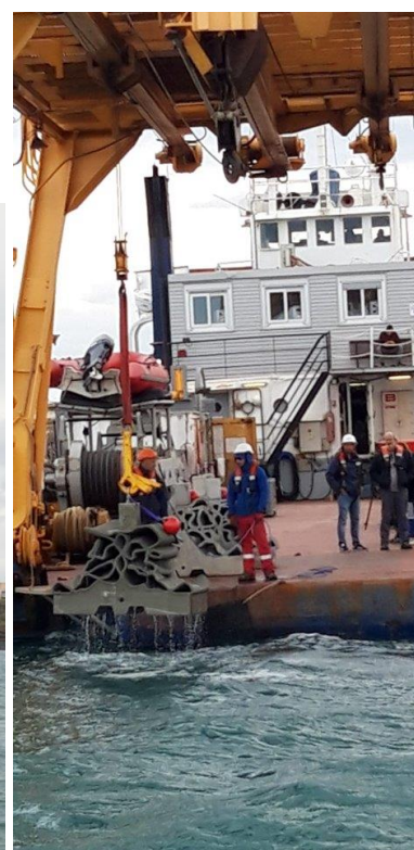
FIGURE 47 : MISE A L'EAU DE RECIF DEPUIS UNE BARGE LOURDE AU CAP D'AGDE POUR LE DEPLOIEMENT DE 32 LESTS DE BALISAGE ECOCONCUS PAR CROCHET AUTOLARGABLE(© SEABOOST, 2019)
