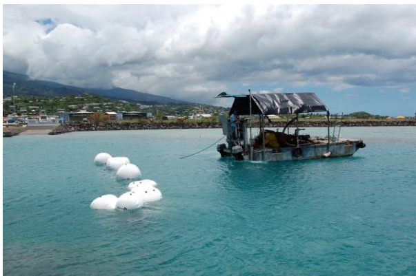
FIGURE 46 : PHOTO 1 REMORQUAGE DE RECIFS ARTIFICIELS DANS LE LAGON DE TAHITI (© PROJET P2A DEVELOPPEMENT). PHOTO 2 REMORQUAGE DE RECIFS ARTIFICIELS ET VUE SOUS-MARINE AVEC DES BALLONS DE LEVAGE (© PROJET P2A DEVELOPPEMENT)
