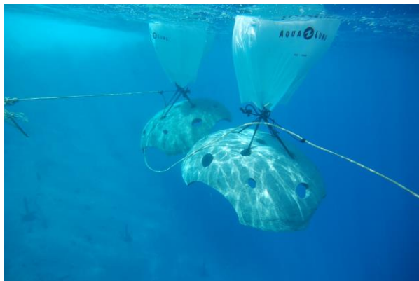
FIGURE 46 : PHOTO 1 REMORQUAGE DE RECIFS ARTIFICIELS DANS LE LAGON DE TAHITI (© PROJET P2A DEVELOPPEMENT). PHOTO 2 REMORQUAGE DE RECIFS ARTIFICIELS ET VUE SOUS-MARINE AVEC DES BALLONS DE LEVAGE (© PROJET P2A DEVELOPPEMENT)
