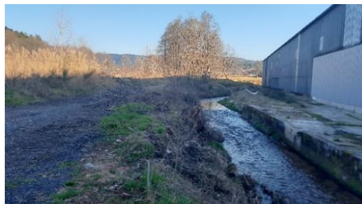
Ruisseau du Moxené (partie aérienne)
