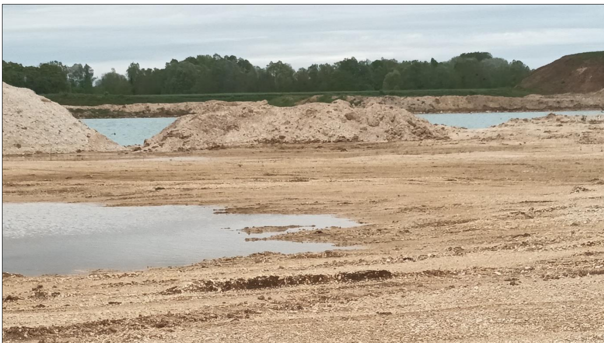
Figure 20 – Décapage superficiel des alluvions modernes pour dégager les alluvions anciennes (cailloutis)
