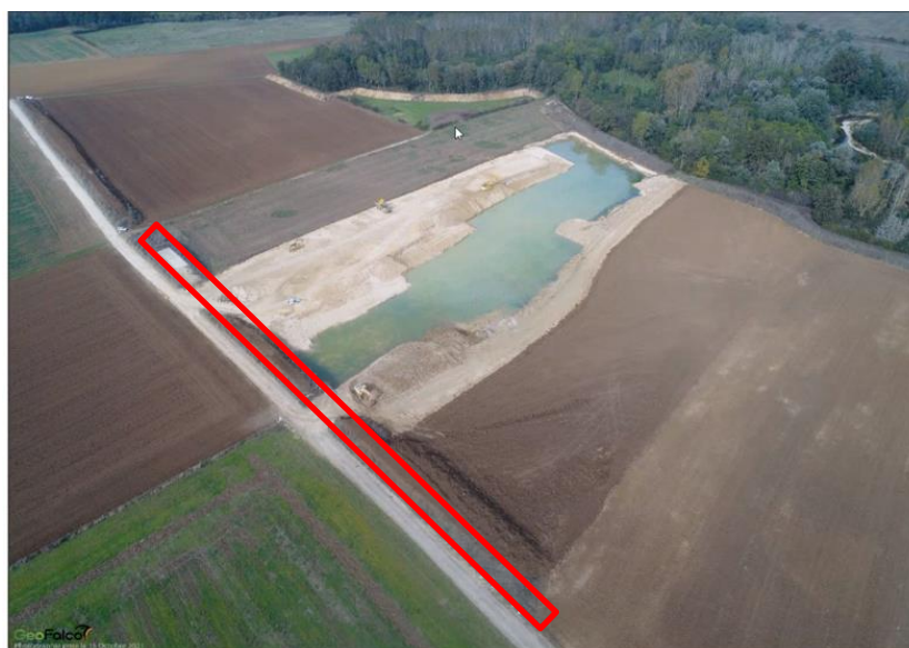
Figure 75 - Photo aérienne de la parcelle ZB 2 en début d'exploitation
