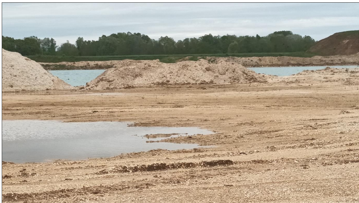
Figure 68 – Décapage superficiel des alluvions modernes pour dégager les alluvions anciennes (cailloutis)
