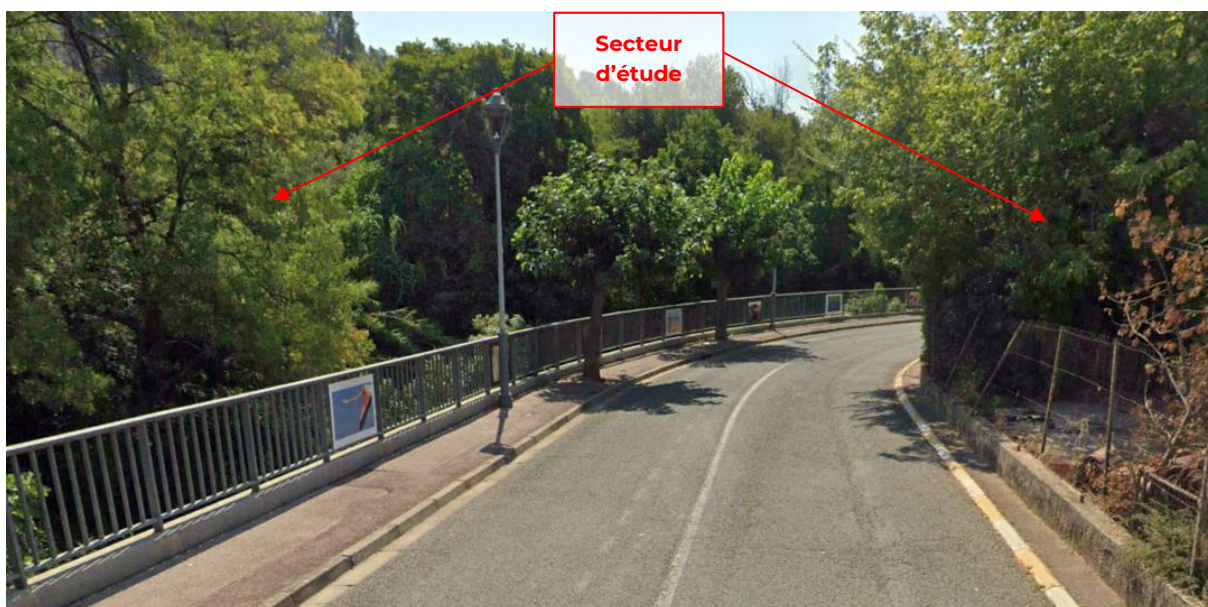
Photo 10 : Vue proche 4 depuis l'avenue Jean Moulin (Google Street)
