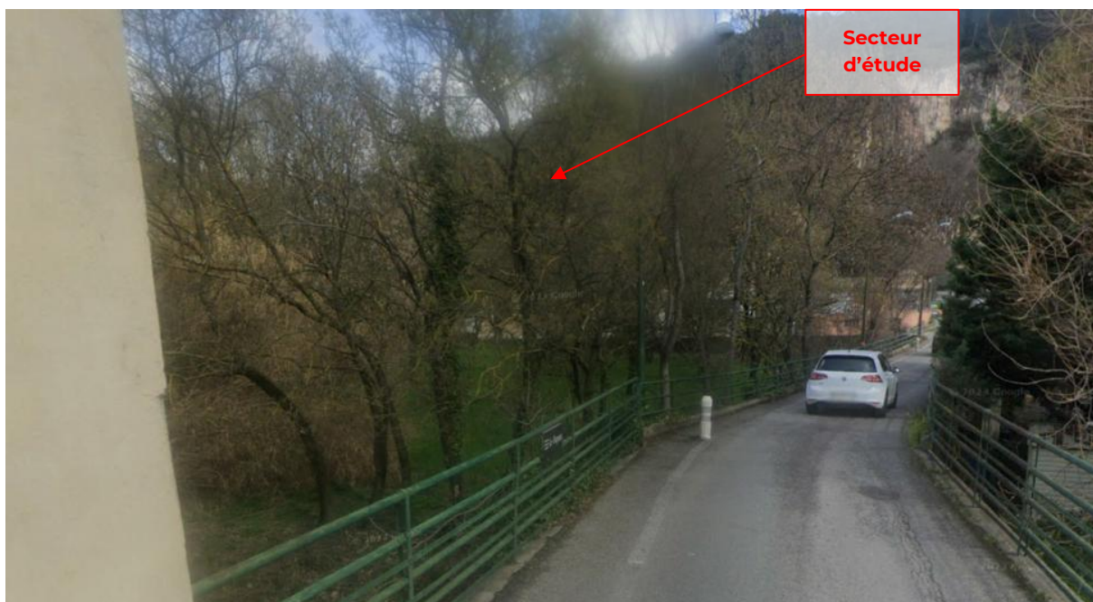
Photo 9 : Vue proche 3 depuis l'avenue Thyde Monnier (Google Street)
