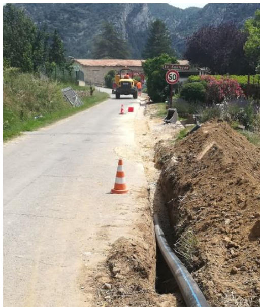
Pendant les travaux de pose
