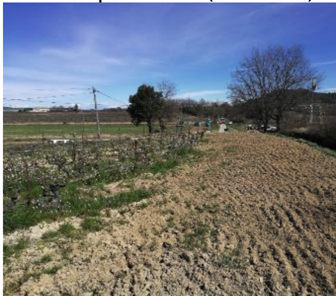
Prise de vue pendant chantier (décembre 2020)
