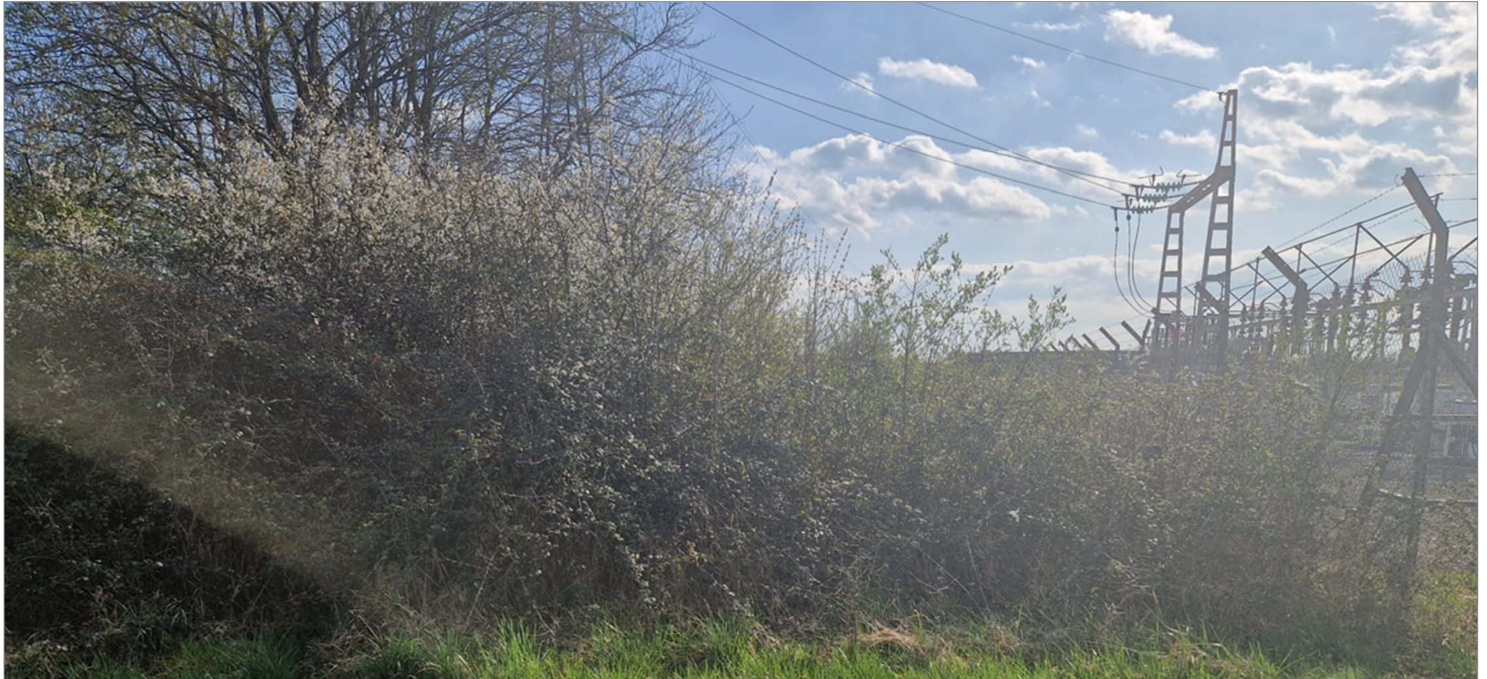
Figure 6 : Photographie de la zone d'étude (Source : Kh Energy)
