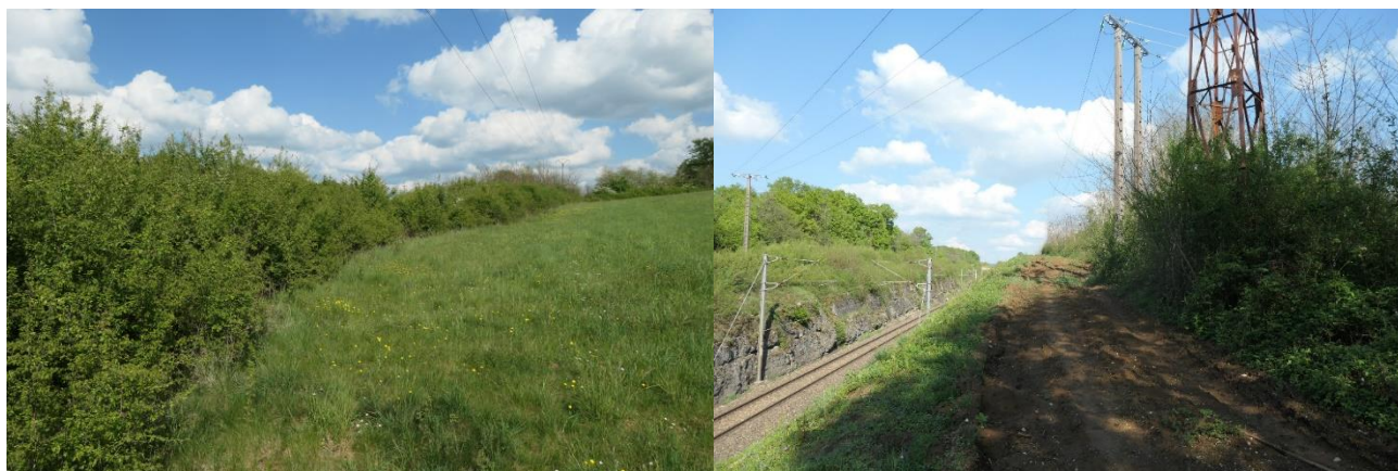
Figure 4 beau réseau de haie arbustive à conserver le long de la VF (lisière sud). La même haie coté voie ferrée est girobroyée et colonisée par les robiniers
