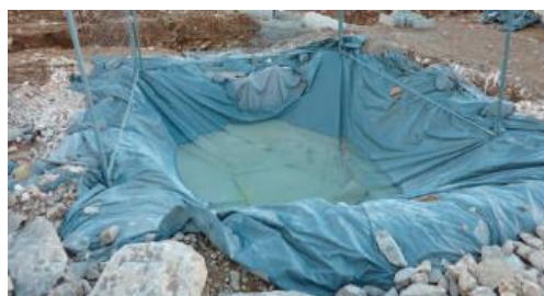
Figure 9. Stockage de matériaux polluants sur lieu étanche (à gauche) et fosse étanche de récupération des résidus de nettoyage, laitance béton, etc. (à droite)
