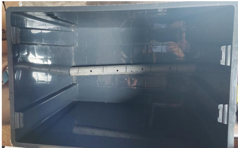
Figure 35 : Photographie du drain placé en pente au fond du bac du Jardin Filtrant®
