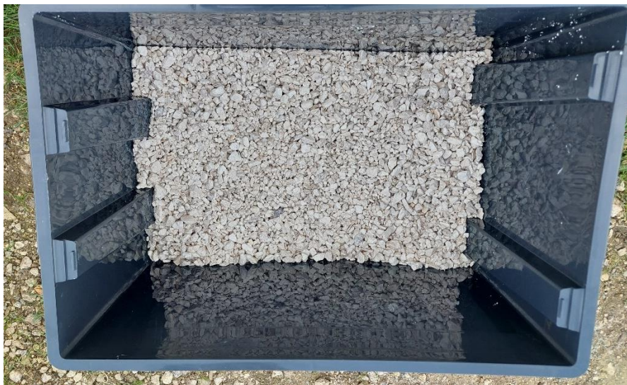
Figure 36 : Photographie du gravier recouvrant le fond du bac du Jardin Filtrant® (couche de 10 cm)
