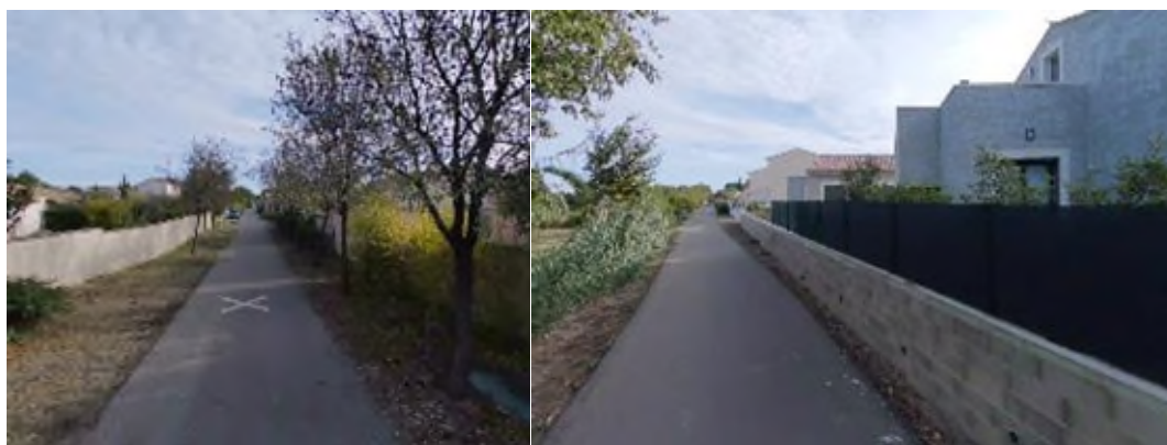
Figure 10 : Pose des futures conduites sous l'Euro vélo 8 – Source Google Map
