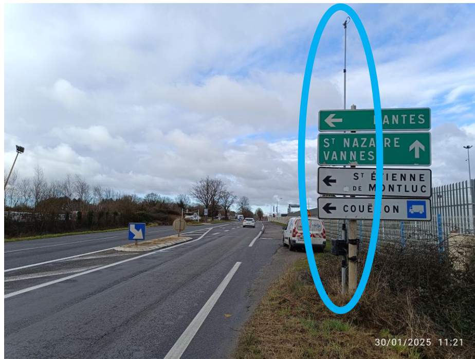
Exemple de mât de comptage au niveau du carrefour Nord
