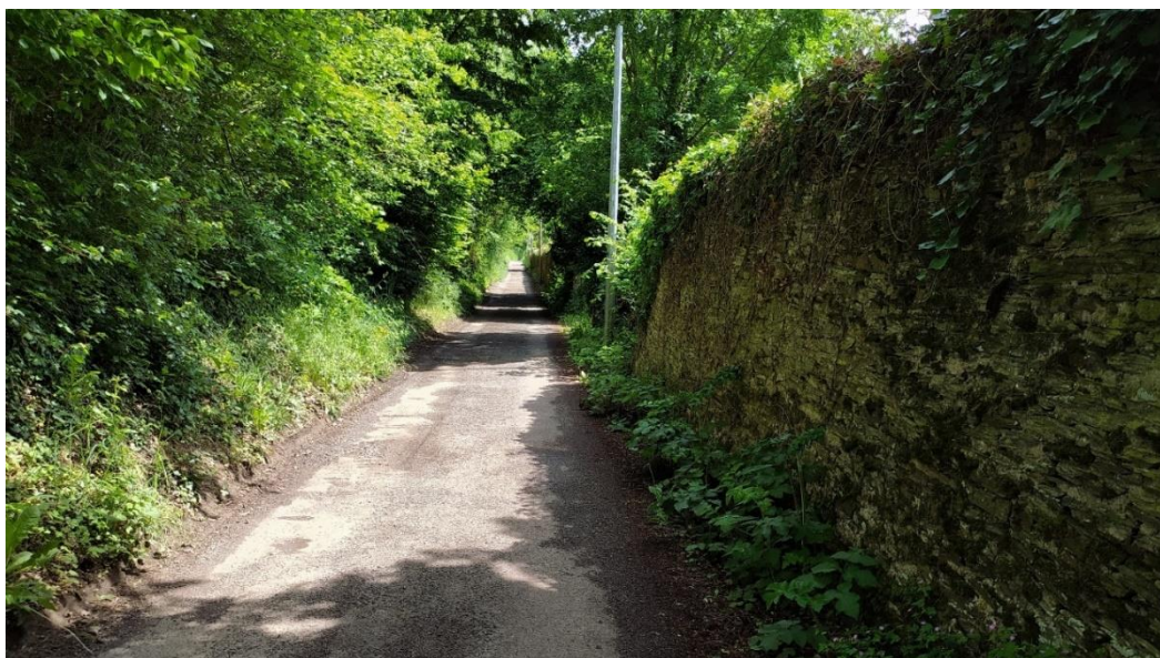
Mur de clôture Nord (vue depuis le chemin des Tranchandières - amont du site)
