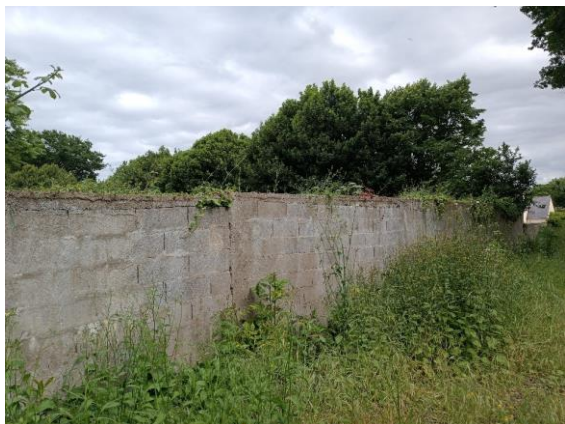
86 Muret en parpaing
