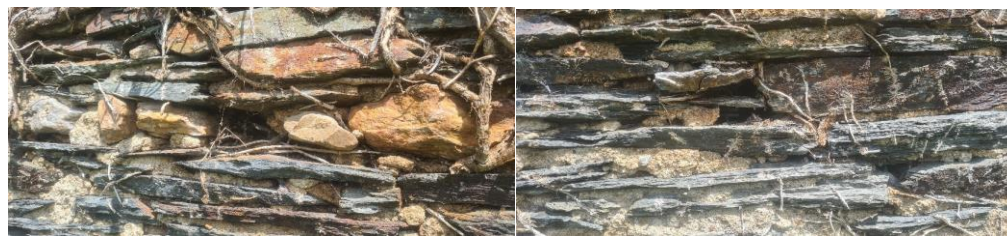
Figure 12 : Cavités présentes dans le muret en schiste
