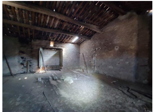
Figure 20 : Photographie des combles
