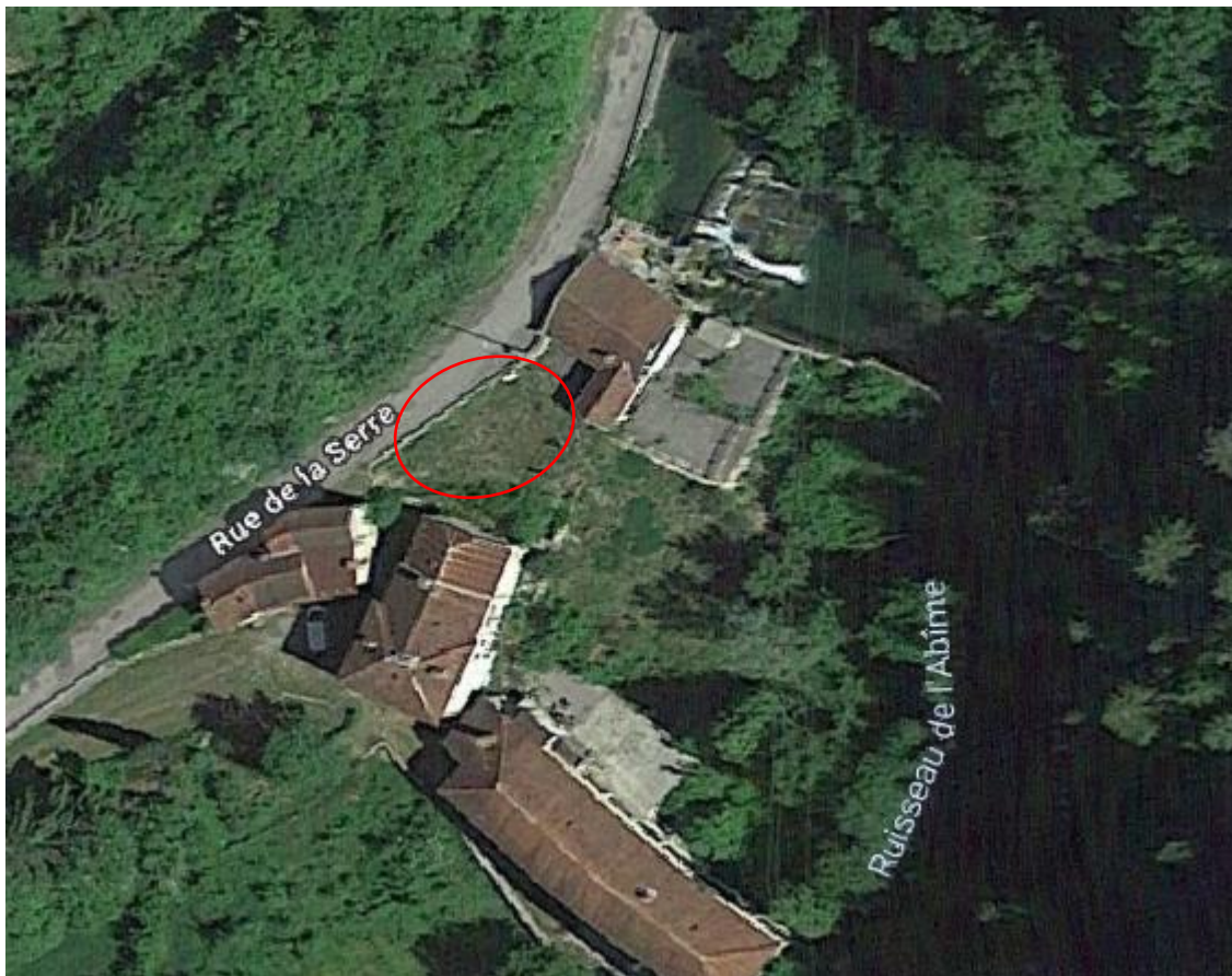
Figure 7 : Zone de stockage des engins de chantier
